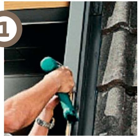
**La luce naturale** è ottenuta realizzando un lucernario a tetto. Per definire la dimensione della finestra ideale, bisogna valutare le dimensioni dell'ambiente e degli interassi fra le travi del tetto.
