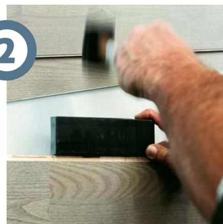
**Il pavimento esistente** è stato sostituito con un parquet prefinito flottante color frassino. Questo tipo di posa permette la sostituzione di un pavimento senza dovere eliminare l'esistente.
