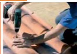
Distribuire i fissaggi in corrispondenza del telaio di supporto, sulla sommità delle lastre, alla base ed al bordo. In qualsiasi altra parte basta un fissaggio ogni due onde (4 fissaggi/mq).
