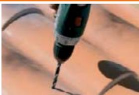
Forare le lastre con punta da mm 10 e fissare con viti da mm 6 per consentire una corretta dilatazione. Utilizzare viti auto-maschianti per fissaggi su metallo ed autofilettanti per fissaggi su legno.
