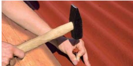
Fissare le lastre con un minimo di 20 chiodi a lastra
