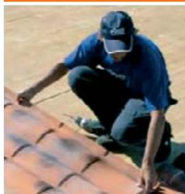
Fissare le lastre con viti e cappellotti direttamente sulla struttura.
