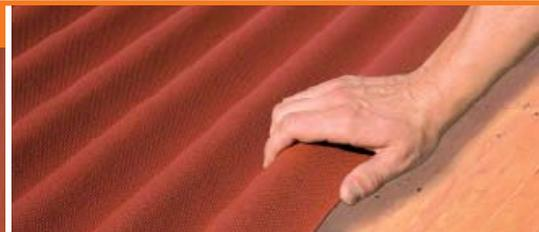
Sormontare le lastre di un'onda
