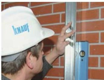
Fissare i montanti ad U al pavimento e al soffitto
