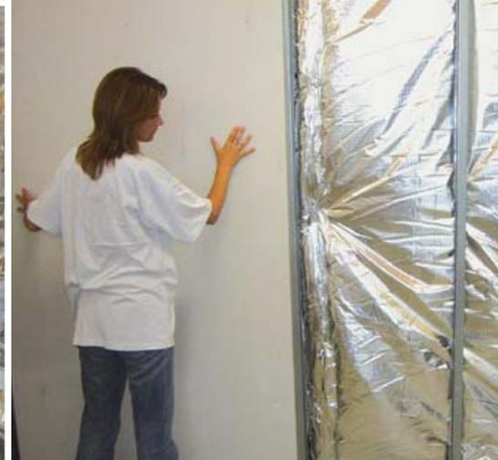
Sovrapporre il pannello in cartongesso avendo cura di non danneggiare l'isolante
